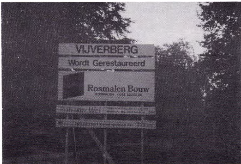
De Vijverberg in 1996 tijdens de restauratie.
