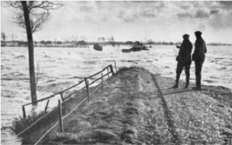
Den doorgebroken Maasdijk
