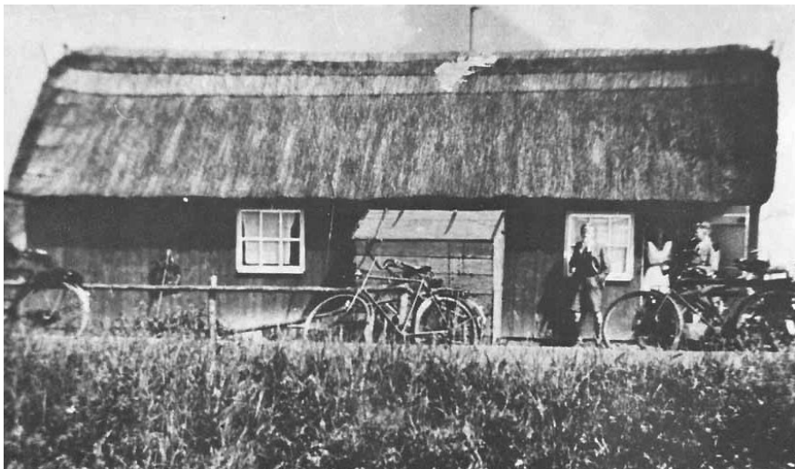
Koelewijn hut in de Rosmollese polder
