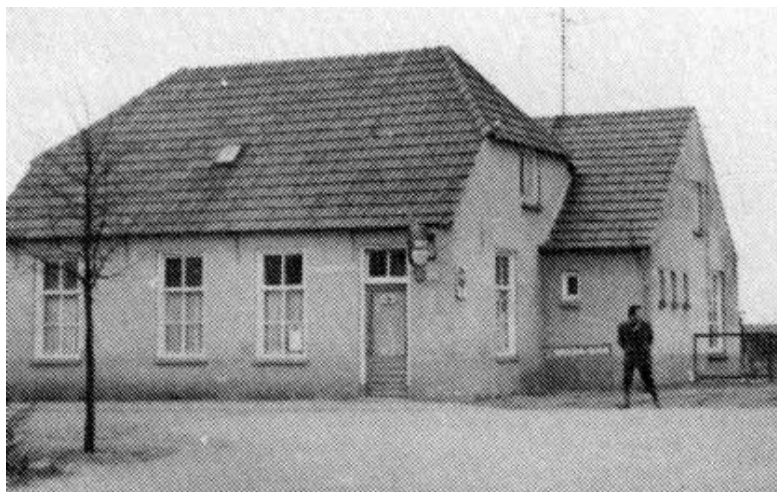
Café De Schaapstal aan de vroegere Tweeberg (afgebroken)
