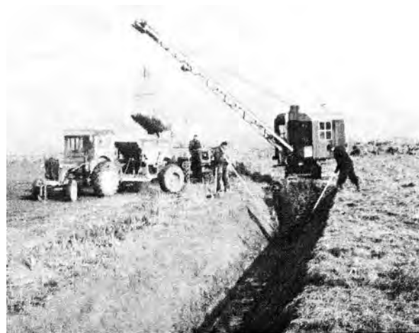
Werkzaamheden voor de ruilverkaveling in de Rosmalense polder 1956
