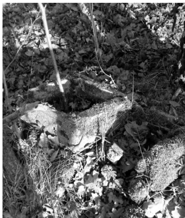
Er zijn nog enkele resten van de torenfundering te vinden
