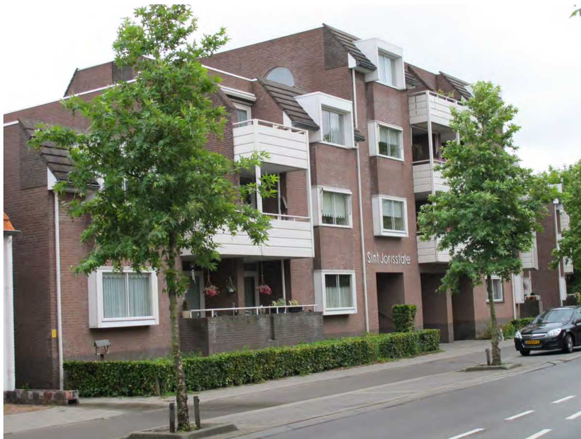
Appartementencomplex Sint Jorisstate, in 1988 gebouwd op de plek waar voorheen villa St. Joris stond, juni 2011 (foto Michiel van Heumen)
